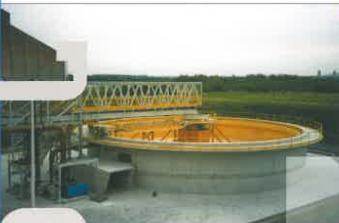
Bezinkkuip Settling tank Bassin de décantation Absetzbecken
