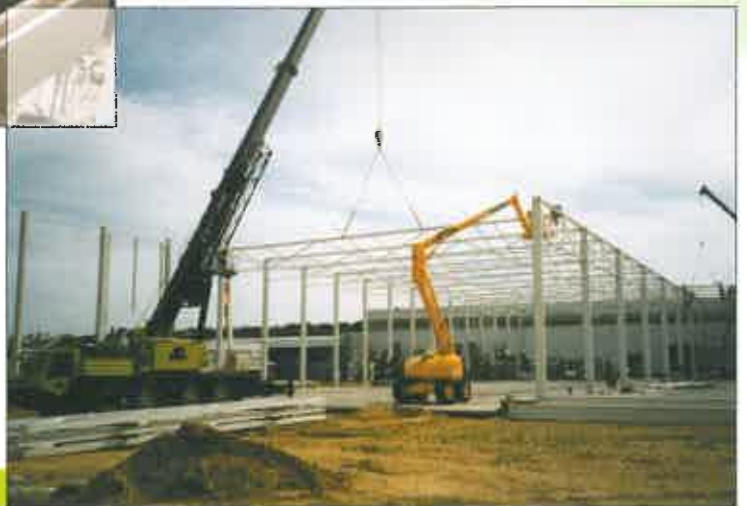
Montage staalconstructie productiehal Installation of steelbuilding for a factory Montage de construction en acier pour une usine Montage Stahlbau Fabrikgebäude
