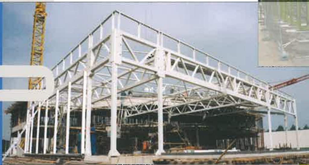
Montage staalconstructie toonzaal Installation of steelbuilding for a show room Montage de construction en acier pour une salle d'exposition Montage Stahlbau Schauraum
